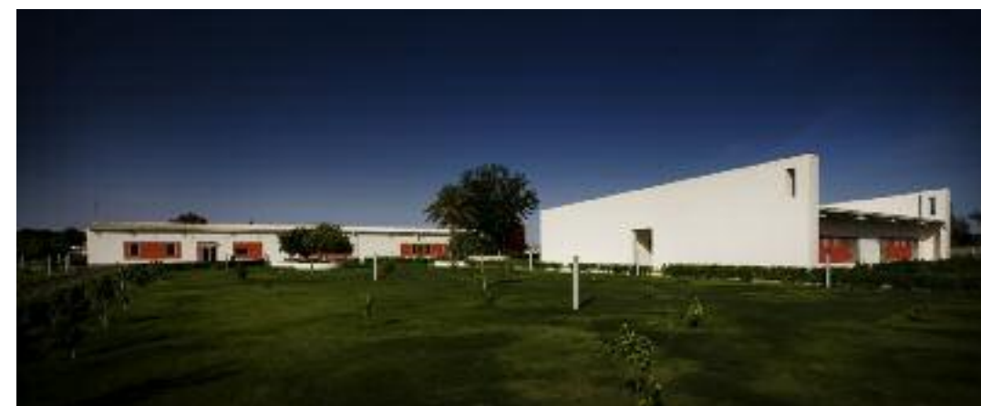
Salam Centre (Sudan) Sopra: padiglione per la preghiera, viste interne; sotto: panoramica del centro chirurgico e della foresteria foto di Marcello Bonfonti
