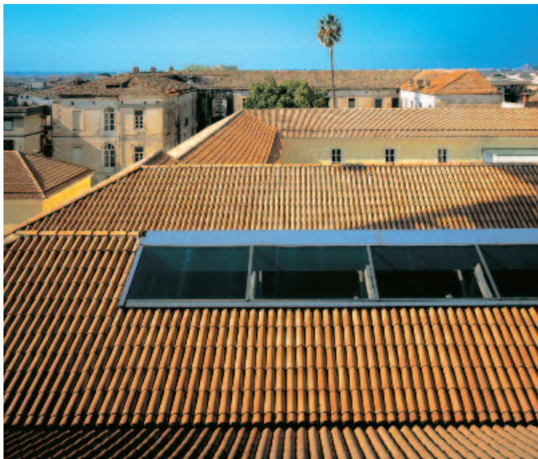
Casagiove, "L'altraReggia" (progetto Corvino+Murtari) La copertura dell'edificio
